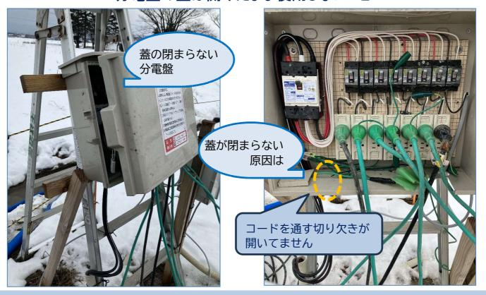
新品の分電盤BOXはコードを通す切り欠きが開いていないため、使用する際に下の写真のように切り欠き部分をプライヤーやペンチなどて掴んでひねり、バキッと開けてください
