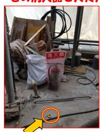
ピンが落ちてる?? もしかして 使用済み??
